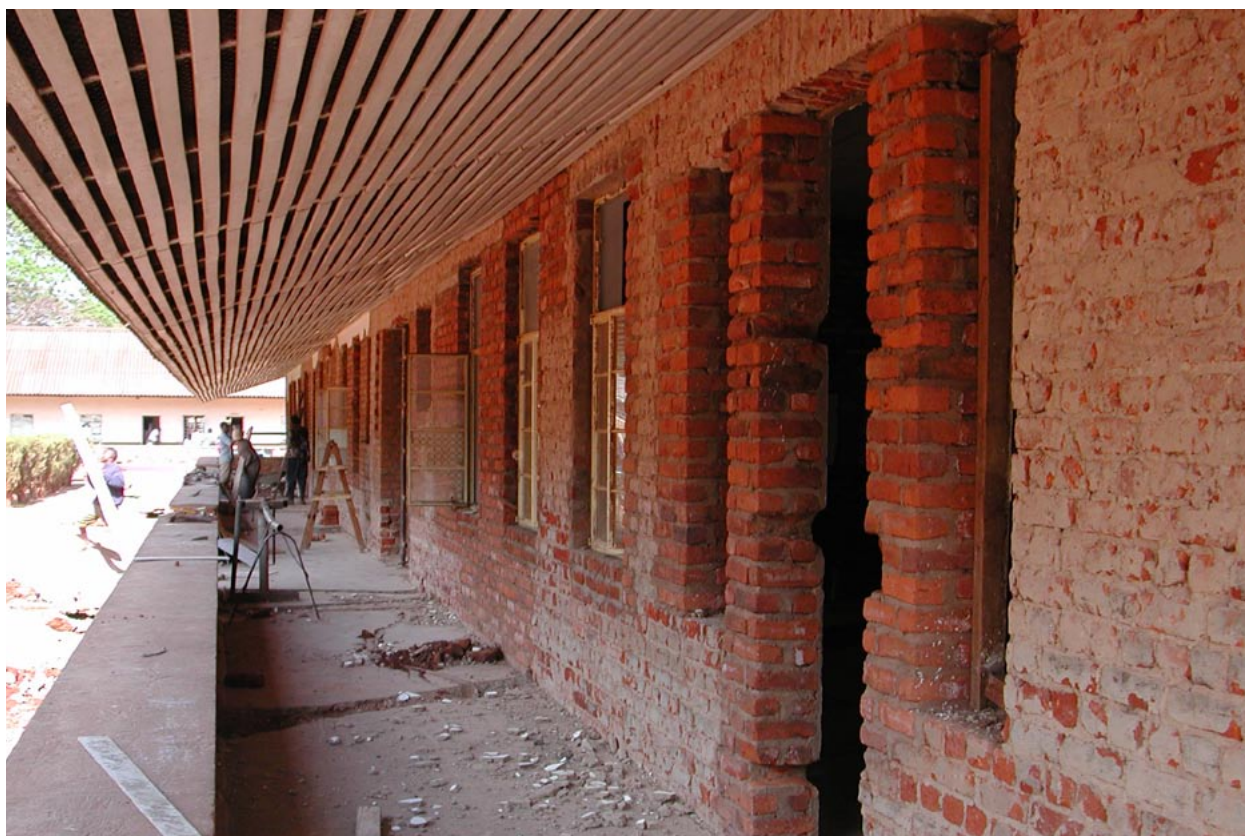
Die Grundstruktur der in die Jahre gekommenen Gebäude sollen mit dem Umbau bestehen bleiben
