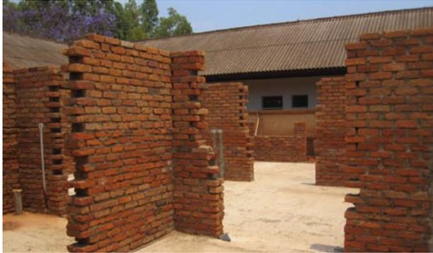
Elektrische und sanitäre Vorinstallationen sind gemacht. Für eine gute Stabilität wird noch ein zusammenhaltender Betonring auf die Grundmauern gegossen.
