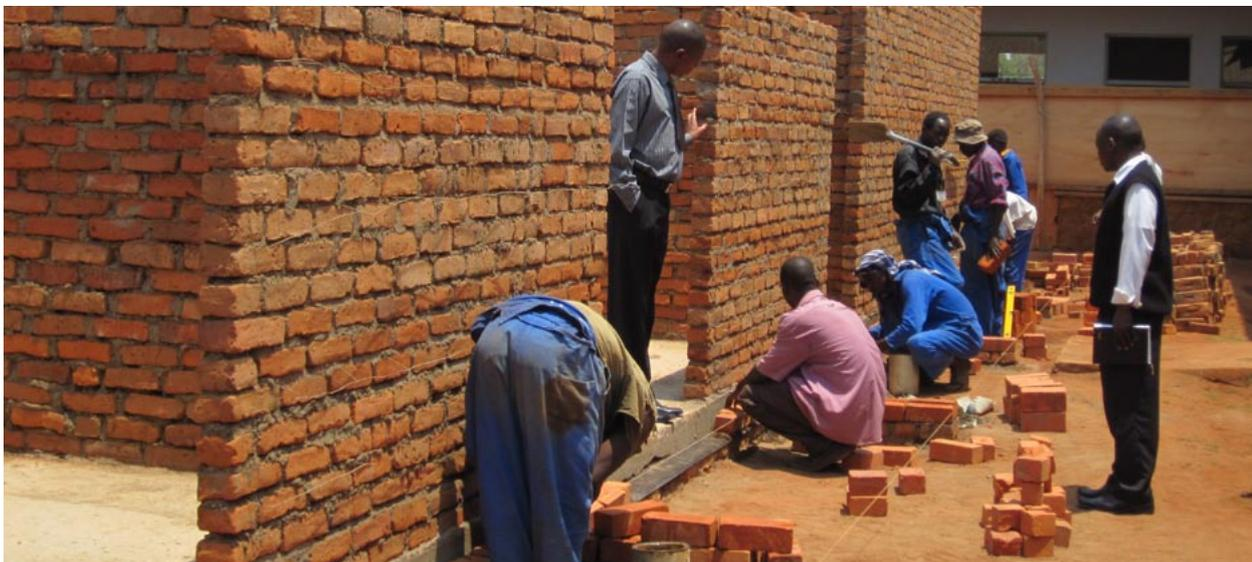
Das Fundament und die Grundmauern des neuen Operationstrakt sind erstellt – der nächste Schritt ist das Aufbauen der Aussenfassade mit keramischen Bausteinen
