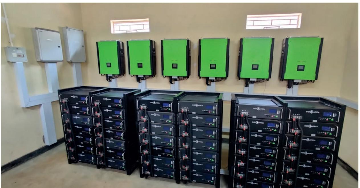
Power für das Spital Phalombe – Lithium-Eisenphosphat-Batterien mit montierten Wechselrichtern im Power-House
