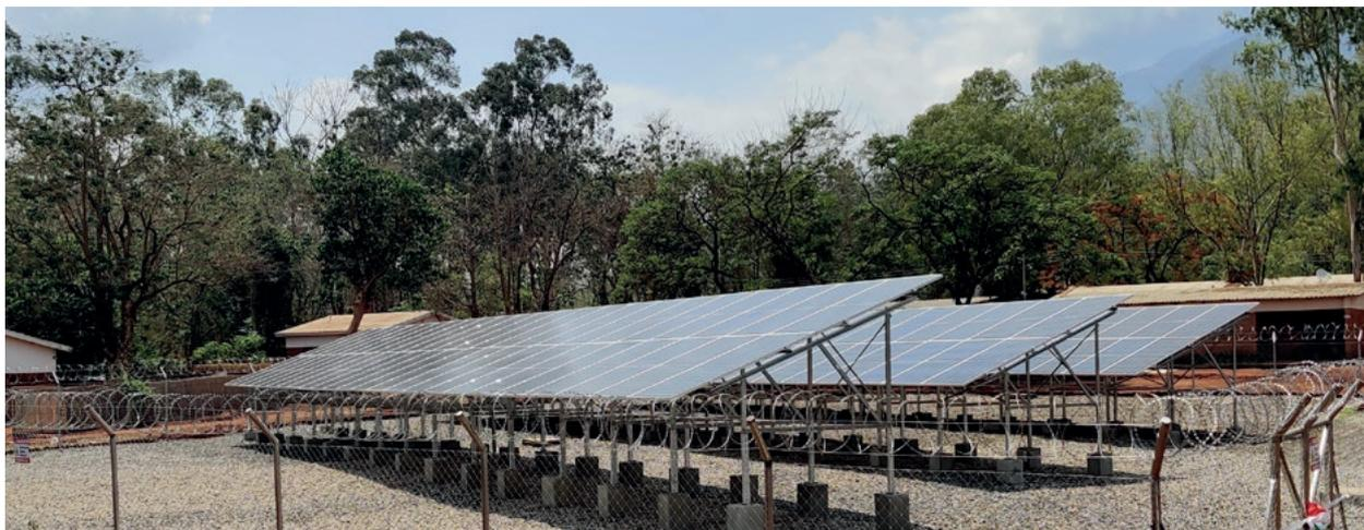
4×24 und 2×26 Solarmodule generierten pro Stunde durchschnittlich 28 kWh – knappe 280 kWh pro Tag (Messergebnisse vom 14. bis 16. Oktober, zwischen 7 und 15 Uhr)
