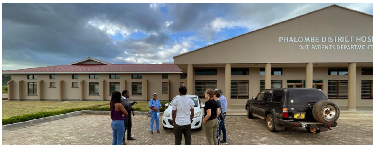
Das ungenutzte, funkelnagelneue Distriktspital in Migowi
